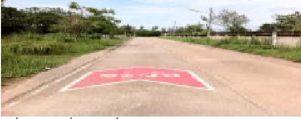
รูปที่ 3 เส้นทางที่เลือกเส้นที่ 1 ถนนคสล.หน้ากว้าง 6 เมตร เกาะหนอง-โบสถ์ โดยวางแผนชะลอรูปทรงCircular
