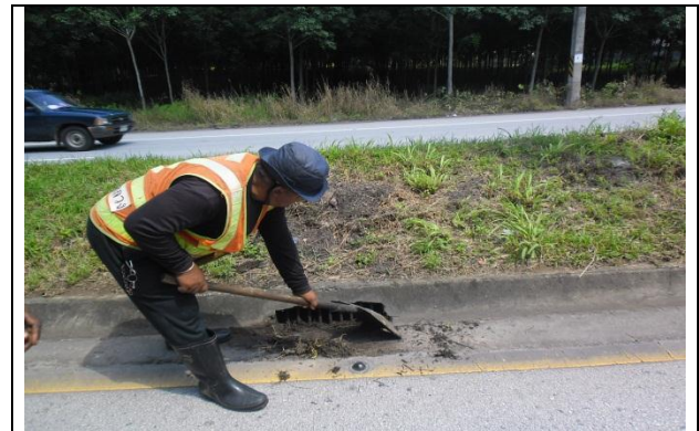
รูปที่ 9 การทำความสะอาดช่องระบายน้ำ
