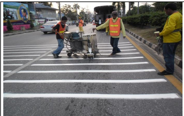
รูปที่ 7 การติดตั้งสันรนาด (Rumble Strips)
