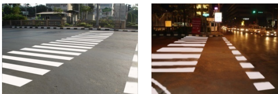
รูปที่ 13 เครื่องหมายจราจรและเครื่องหมายนำทางหลังการปรับปรุงสีเครื่องหมายจราจรที่ลบเลือน
