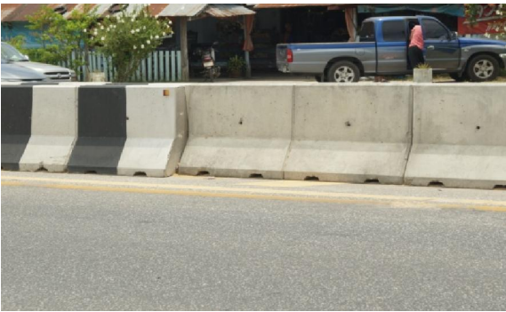
รูปที่ 14 การเปิดฐานกำแพงคอนกรีตเพื่อระบายน้ำ
