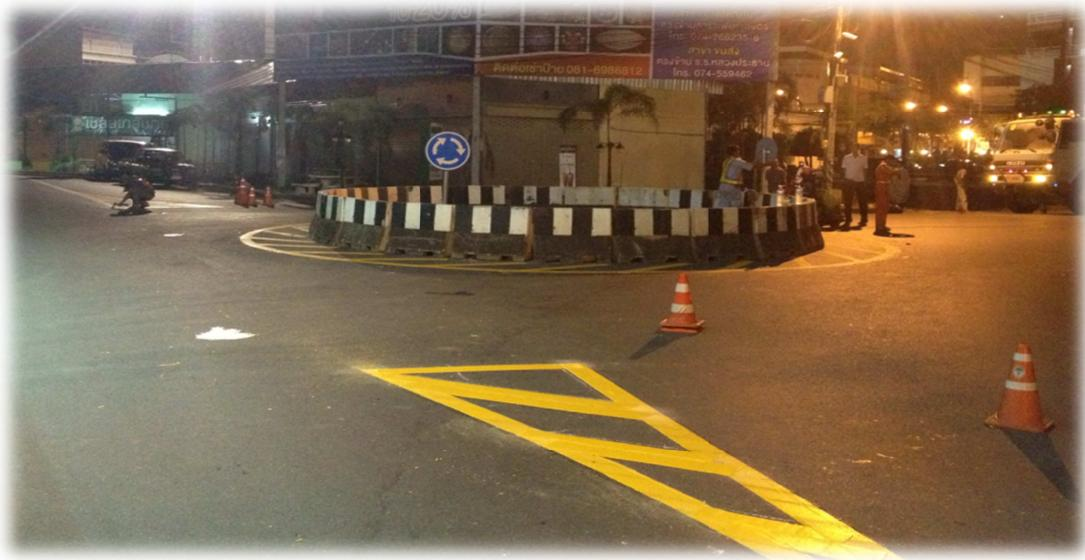
รูปที่ 4.16 ตีสีเทอร์โมพลาสติก แบ่งช่องจราจร และติดตั้งป้ายจราจร
