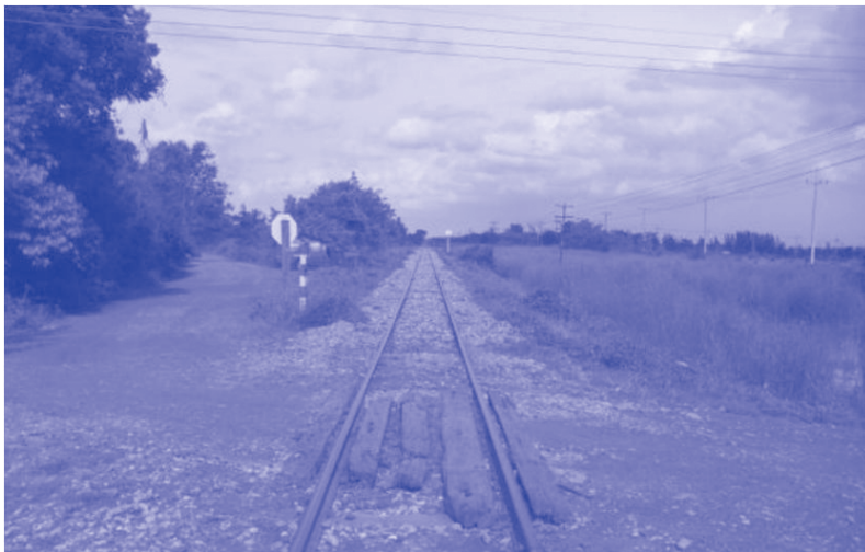
ภาพที่ 5.4 ลักษณะทางข้ามทางรถไฟที่ไม่ตั้งฉากกับแนวราง
