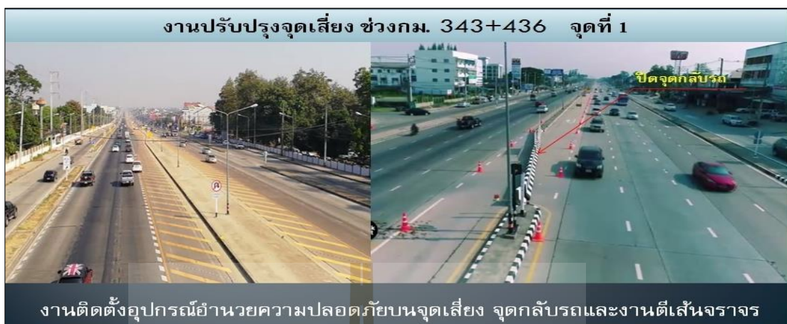
รูปที่ 2.10 งานติดตั้งอุปกรณ์อำนวยความสะดวกความปลอดภัยบนจุดเสี่ยงจุดกลับรถ ที่กม.343+436 (แขวงการทางขอนแก่นที่ 1, 2561)
