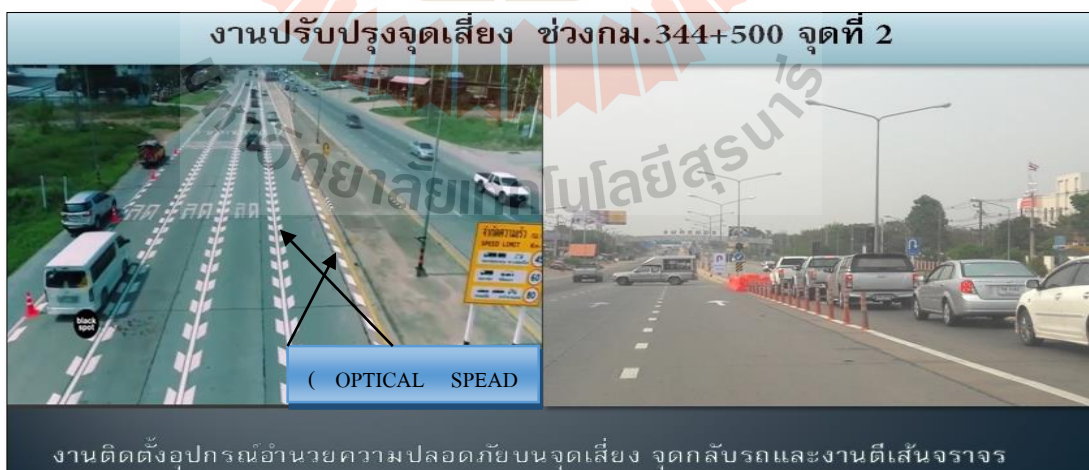
รูปที่ 2.11 งานติดตั้งอุปกรณ์อำนวยความสะดวกและงานตีเส้นจราจรบนจุดเสี่ยง จุดกลับรถ ที่กม. 344+500 (แขวงการทางขอนแก่นที่ 1, 2561)
